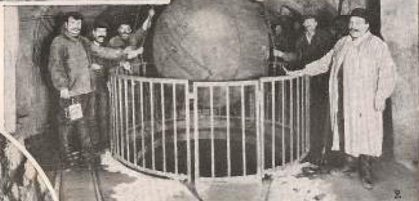
**Fig. 2. Boule de curage du siphon de la Concorde.** — Les divers siphons, construits sous la Seine et qui permettent aux collecteurs de la R. G. de communiquer avec la R. D., sont nettoyés au moyen d'une énorme boule en bois démontable, d'un diamètre un peu plus faible que celui du siphon. La boule engagée dans le siphon et poussée par l'eau, chasse devant elle les sables qu'elle rencontre. Elle met généralement de 2 à 8 jours pour franchir le siphon.
