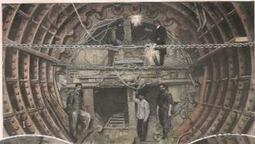
La ligne électrique N.-S. franchit la Seine près du pont de la Concorde dans deux souterrains tubulaires séparés, l'un pour la voie montante, l'autre pour la voie descendante. Le percement de ces souterrains a été fait à l'aide du bouclier dont l'emploi était tout indiqué, en raison de la nature du terrain traversé.
